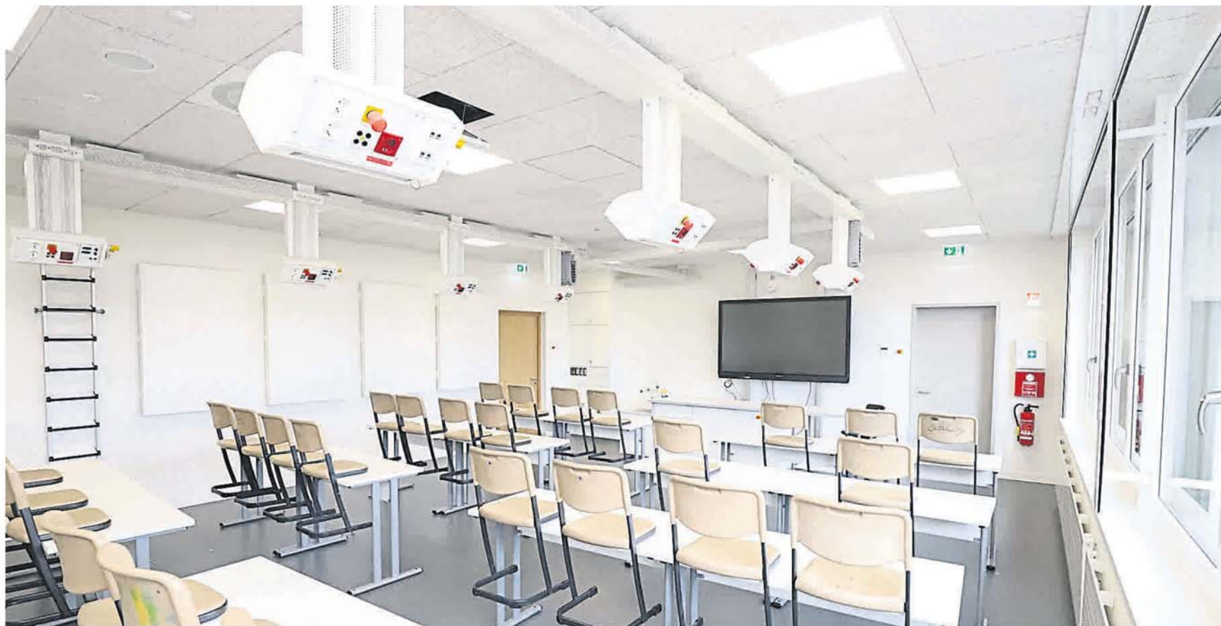
In den Navi-Räumen lassen sich Steckdosenleisten mit weiteren Anschlüssen auf Knopfdruck aus der Decke absenken. Auch der Umgang mit den digitalen Tafeln muss nun eingeübt und vertieft werden.
