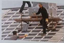
151.1 Arbeiten auf dem Dach
